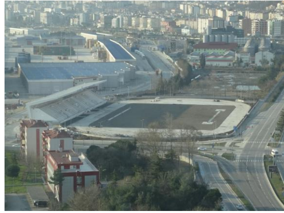
Atletiekpiste in aanbouw (klaar tegen mei 2017)
