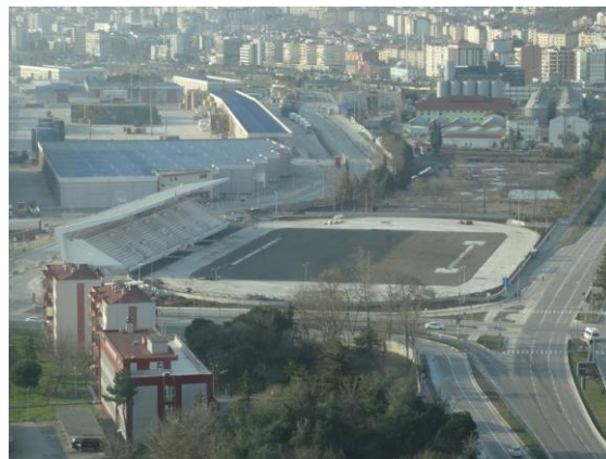
Atletiekpiste in aanbouw (klaar tegen mei 2017)
